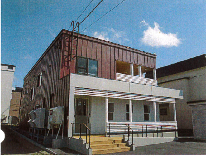
①設置施設写真
